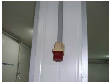
ภาพที่ 27 ติดตั้งสายไฟในท่อติดกับผนังและปลั๊กไฟที่ป้องกันอันตรายจากกระแสไฟฟ้า
