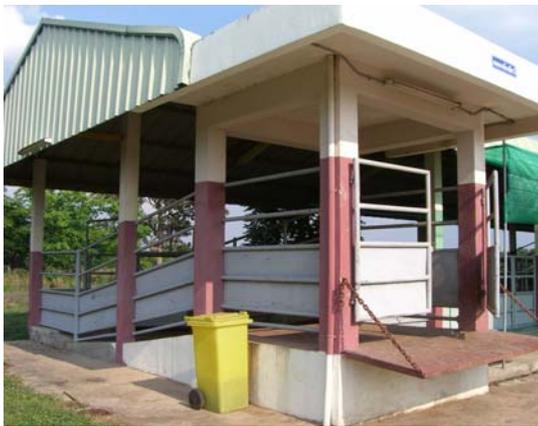
ภาพที่ 3 เทียบให้สุกรลงจากรถขนส่งได้สะดวก
