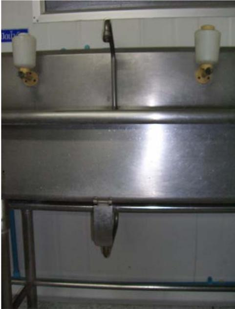
ภาพที่ 11 อ่างล้างมือชนิดที่ไม่ใช้มือหรือแขนปิด-เปิด
